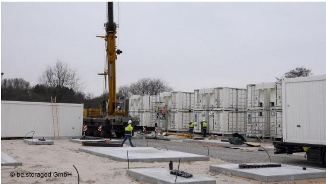
Abb. 7: Aufstellen der Container mit den darin enthaltenen Batteriespeichern (Quelle: enera)
